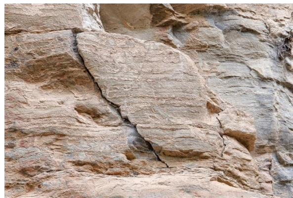
Figura 119 – Termoclastia em processo, detalhe
