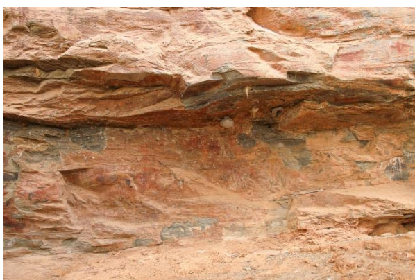
Figura 120 – Locais de presença de vestígios de insetos, aves e/ou morcegos
